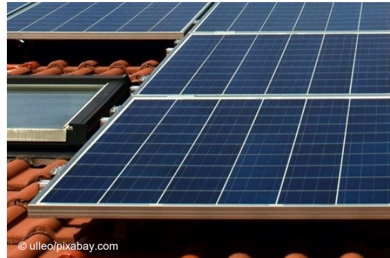
Solarmodul mit 60 polykristallinen Solarzellen
